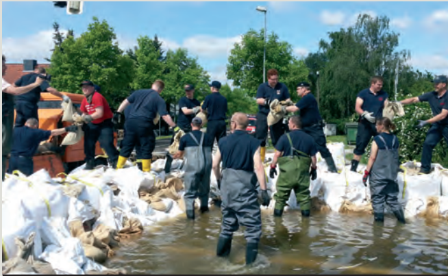
oben: Die Aufgaben der Feuerwehren waren vielfältig: Sie schützten Orte mit Sandsackbarrieren und beförderten durchgesickertes Wasser mit Pumpen zurück in die angeschwollenen Flüsse. (Foto links: Stadt Duisburg, Foto rechts: Feuerwehr Düsseldorf). unten: Höchster Einsatz bis an die Grenzen der Leistungsfähigkeit – wie hier beim Einweisen eines Hubschraubers, der einen »Big Bag« abwirft. (Foto: R. Thumser)
