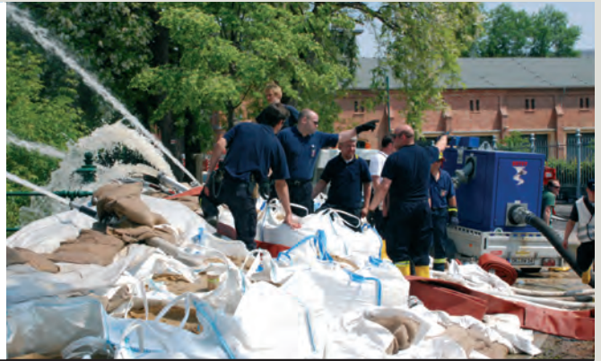
oben: Die Aufgaben der Feuerwehren waren vielfältig: Sie schützten Orte mit Sandsackbarrieren und beförderten durchgesickertes Wasser mit Pumpen zurück in die angeschwollenen Flüsse. (Foto links: Stadt Duisburg, Foto rechts: Feuerwehr Düsseldorf). unten: Höchster Einsatz bis an die Grenzen der Leistungsfähigkeit – wie hier beim Einweisen eines Hubschraubers, der einen »Big Bag« abwirft. (Foto: R. Thumser)
